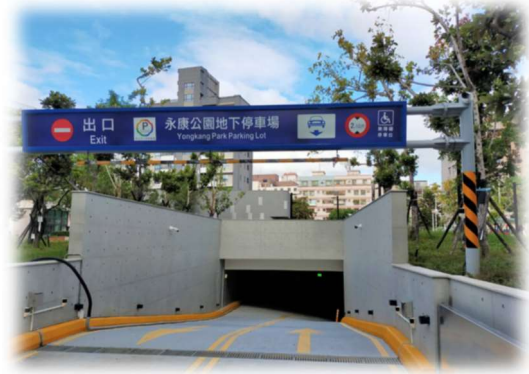
圖 18 永康公園地下停車場入口
