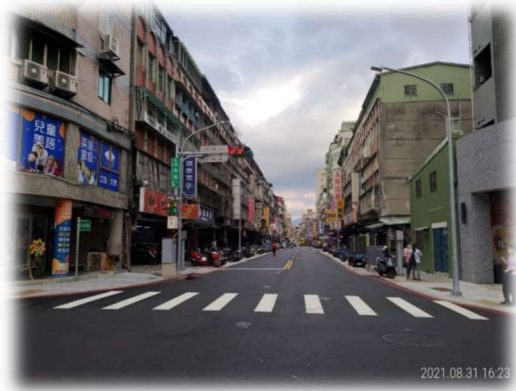
圖 34 道路改善工程後
