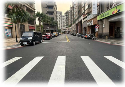
圖 40 道路改善工程後
