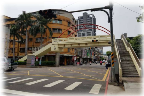
圖 11 蘆中陸橋拆除前
