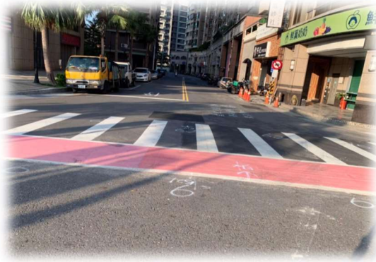
圖 39 道路改善工程前
