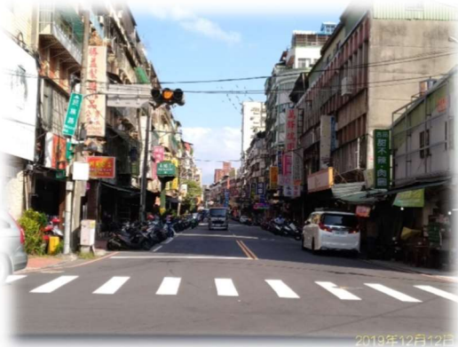
圖 33 道路改善工程前
