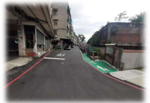
圖 36 道路改善工程後
