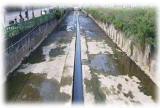
圖 18 蘆洲大排整治工程後
