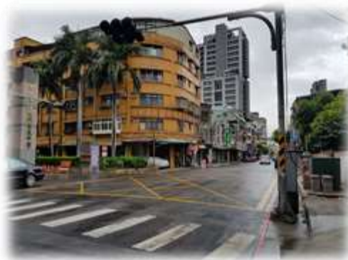
圖 12 蘆中陸橋拆除後
