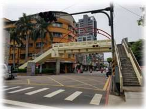
圖 11 蘆中陸橋拆除前
