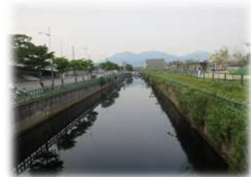
圖 17 蘆洲大排整治工程前
