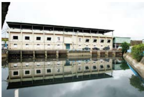
圖 4-3-7 蘆洲抽水站外貌（市長室提供）
