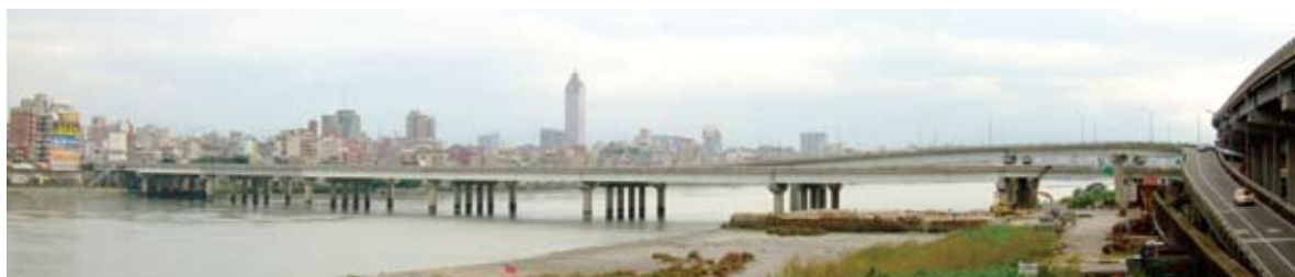
圖 4-3-4 橋樑工程（臺北橋）
