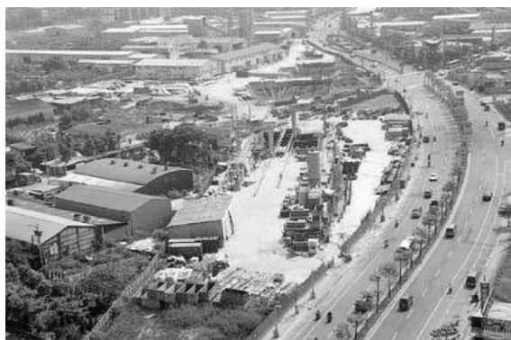
圖 4-4-4 圖臺北捷運蘆洲線蘆洲站施工全貌 (田潔生攝)
