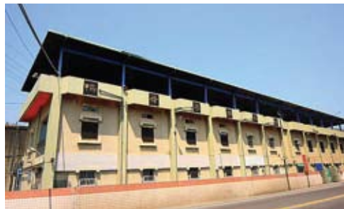
圖 4-3-6 鴨母港抽水站
