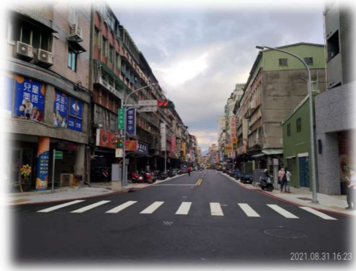
圖 30 道路改善工程後
