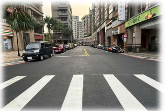
圖 36 道路改善工程後
