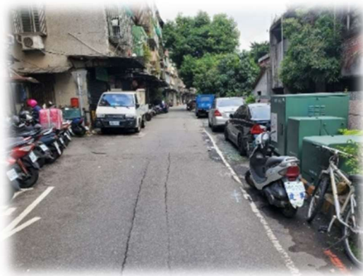
圖 31 道路改善工程前
