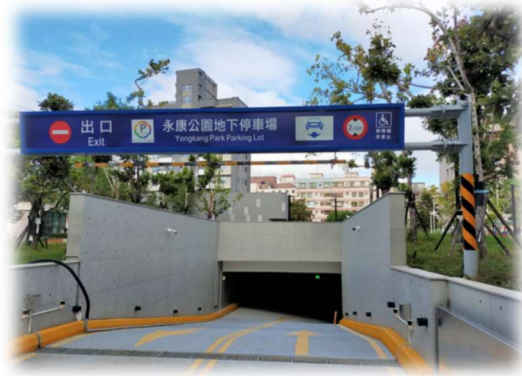
圖 18 永康公園地下停車場入口
