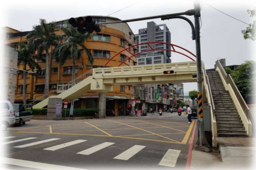
圖 11 蘆中陸橋拆除前
