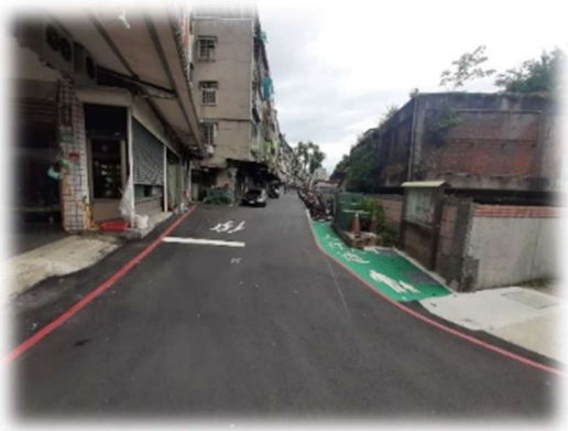
圖 32 道路改善工程後
