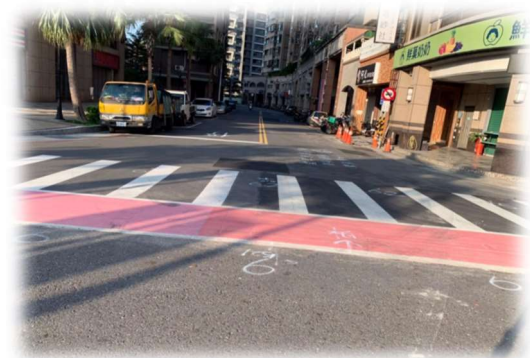
圖 35 道路改善工程前
