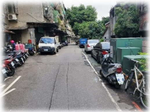
圖 27 道路改善工程前
