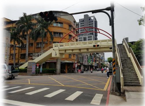
圖 11 蘆中陸橋拆除前
