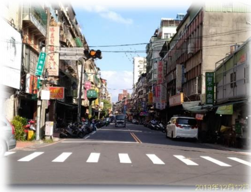
圖 25 道路改善工程前
