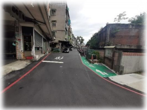
圖 28 道路改善工程後
