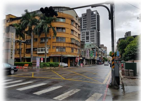
圖 12 蘆中陸橋拆除後
