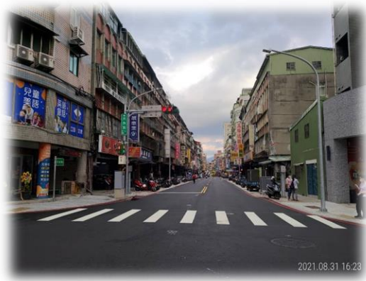
圖 26 道路改善工程後
