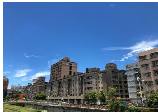
圖 12 永安南路二段高壓電塔拆除後
