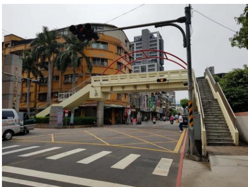
圖 13 蘆中陸橋拆除前
