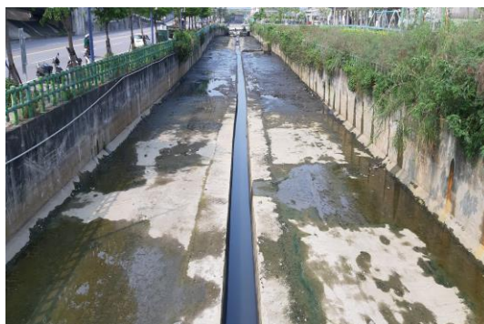
圖 16 蘆洲大排整治工程後
