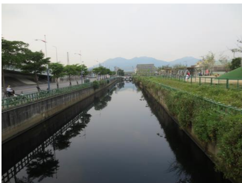
圖 15 蘆洲大排整治工程前
