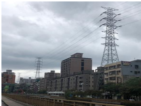
圖 11 永安南路二段高壓電塔拆除前
