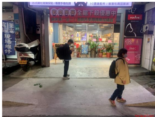
斜坡道改善工程(施工後)
