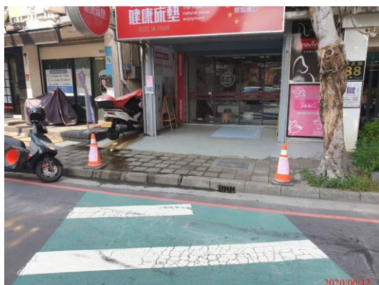
斜坡道改善工程(施工前)
