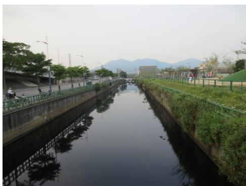
圖 14 蘆洲大排整治工程前
