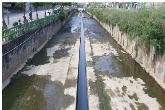
圖 15 蘆洲大排整治工程後
