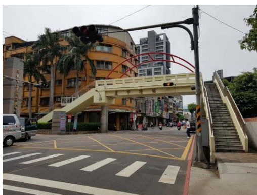
圖 12 蘆中陸橋拆除前
